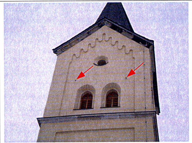
Bild 4: Brutplatz Mauersegler / Haussperling, Turm - Westseite (rote Pfeile)
