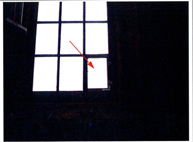
Bild 14: Optimierung Rauchschnalbeneinflug, aushängbares Fenstersegment (rote Pfeil), Fenster Turm – Südseite (Innenansicht)
