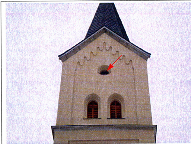
Bild 7: Turm – Nordseite, offene Fensteröffnung (rote Pfeil) mit dahinterstehenden Kombinationsbrutkasten (Schleiereule/Turmfalke)
